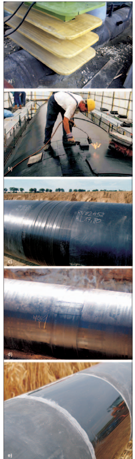
Bild 2: Normungs- und regelwerkskonformer Einsatz von Nachumhüllungsmaterialien: a) Petrolatumband, b) Bitumenband, c) Kunststoffbandsystem, d) Schrumpfmanschette, e) Polyurethan-Schweißnahtbeschichtung Fig. 2: Use of field coatings in accordance with material standards and technical rules: a) Petrolatum tape, b) Bitumen tape, c) Plastics tape, d) Shrink sleeve, e) Polyurethane joint coating
